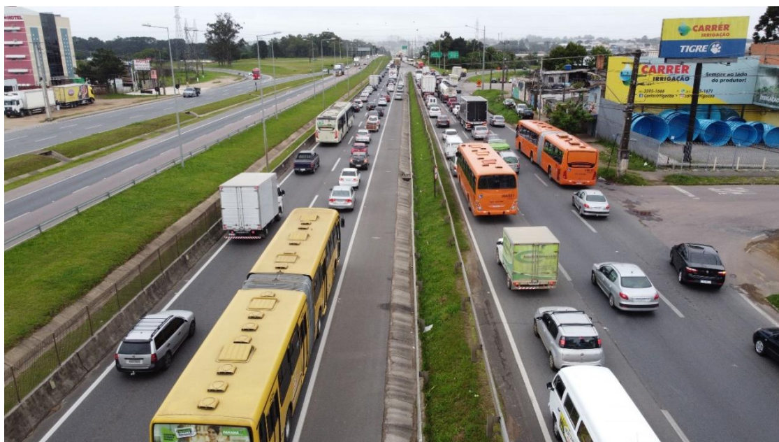
Figura 4 - Tráfego diário no entroncamento da BR-116 com o Contorno Leste de Curitiba
